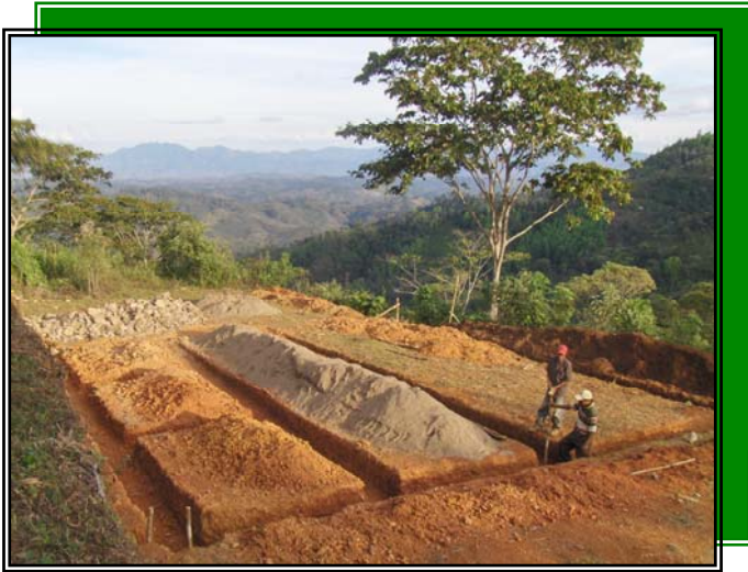
Construcción de la sede el guano Marzo 2007
